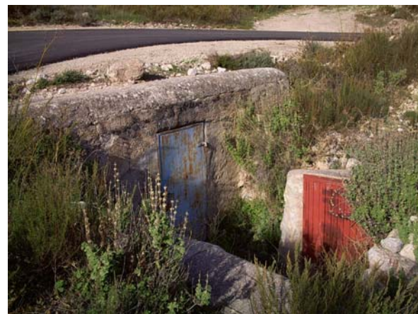
Partidor de agua (Punto 2 de la fig. 8) (Jorge Jiménez Sánchez)
